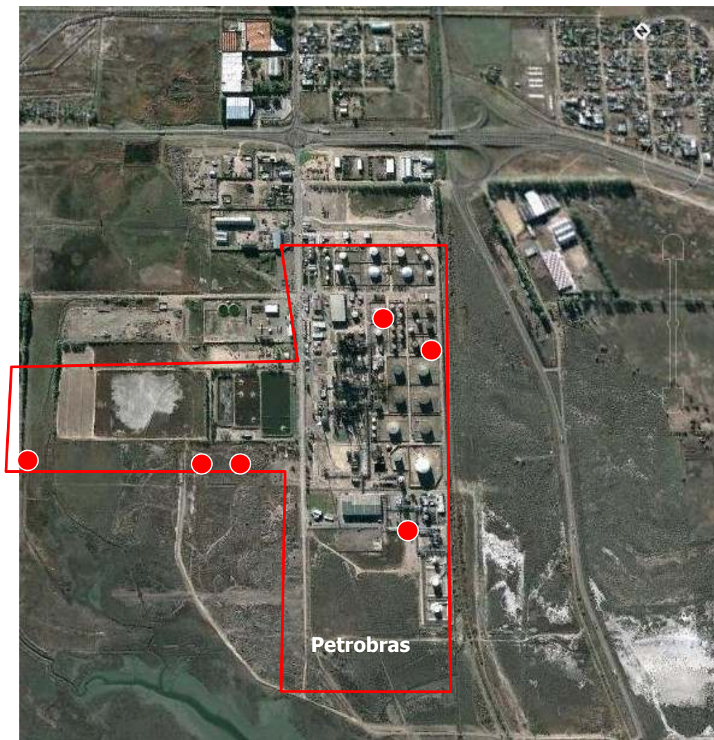
Figura 3. Ubicación de los pozos de monitoreo internos de planta. Detalle de la empresa Petrobras.
