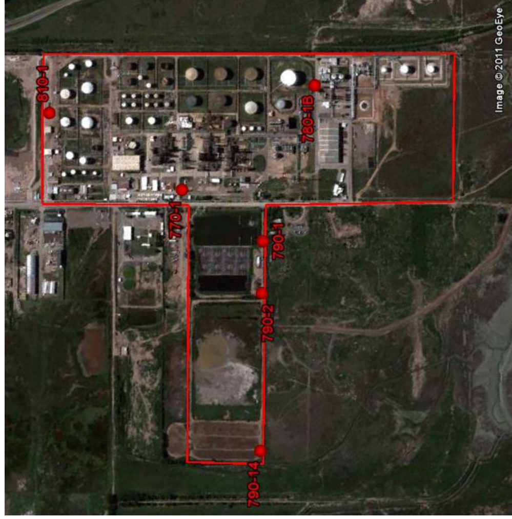
Figura III, Ubicación de los pozos de monitoreo internos de planta, Detalle de la empresa Petrobras Argentina S.A.
