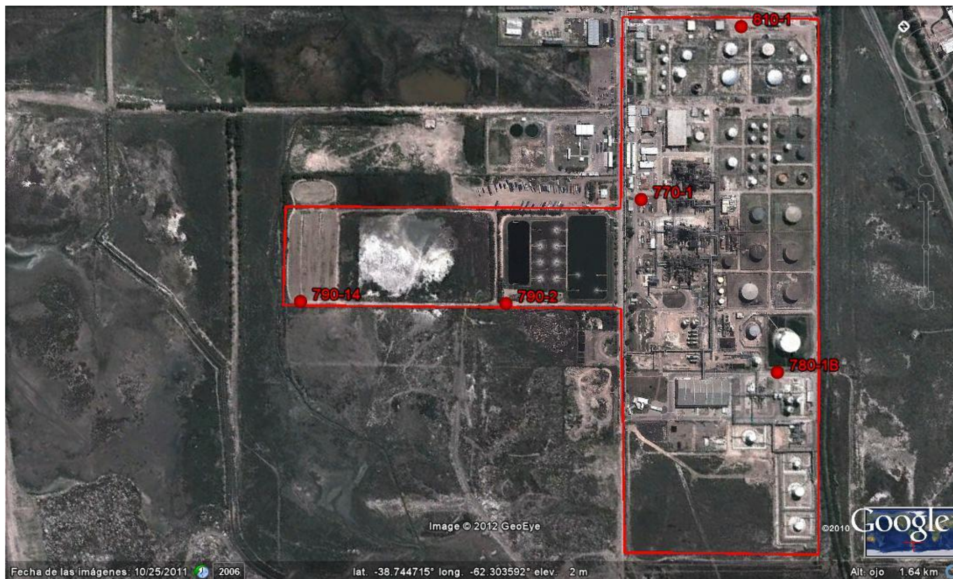
Figura 3, Ubicación de los pozos de monitoreo internos de planta, detalle de la empresa Petrobras Argentina S.A.
