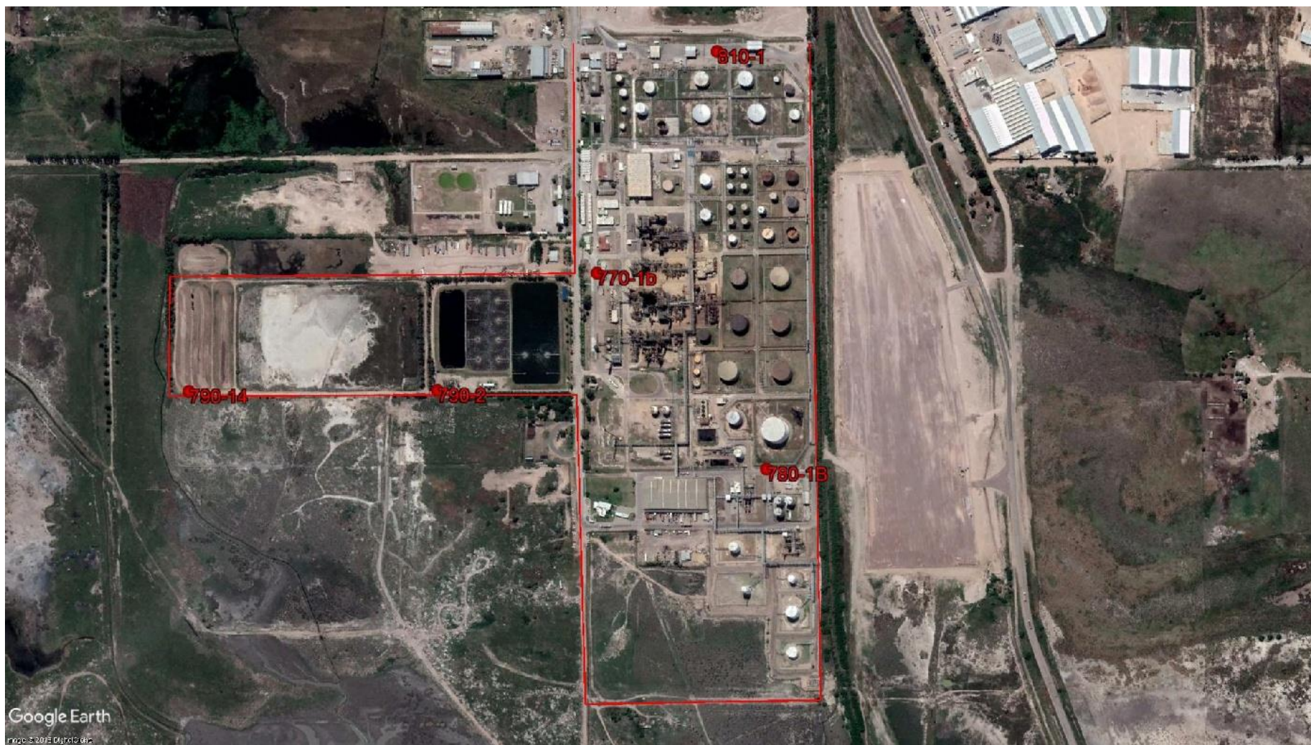
Figura 3, Ubicación de los pozos de monitoreo internos de planta, detalle de la refinería Pampa Energía S.A.
